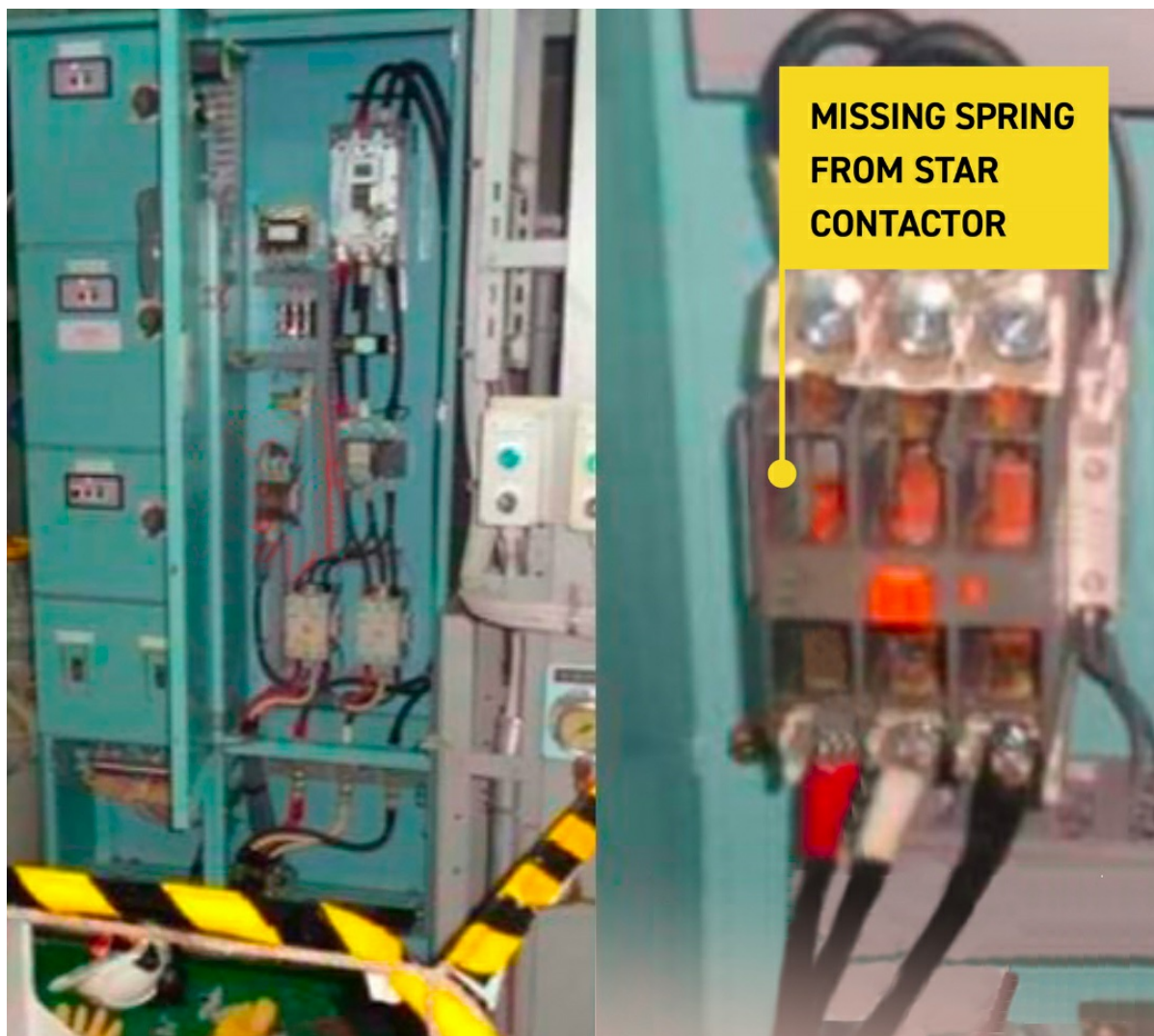
Figur 3 IG-skrubberpumpestarterkontakter og manglende stjernekontaktorfjær.
