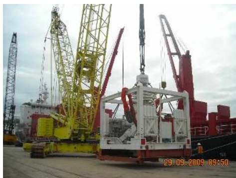
129 tonn BOP lastes av landkran.
