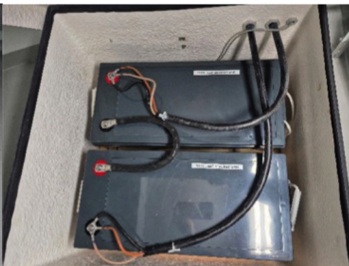
To batterier i serie 2 \times 12 \text{ V} = 24 \text{ V}
